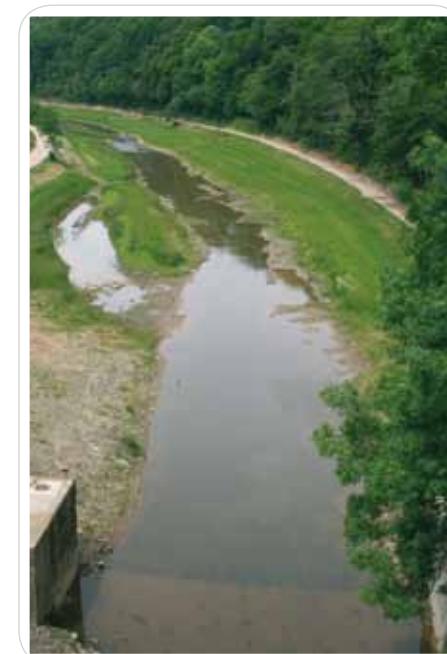
La suppression de l'ouvrage a permis au Vicoin de retrouver un fonctionnement naturel
