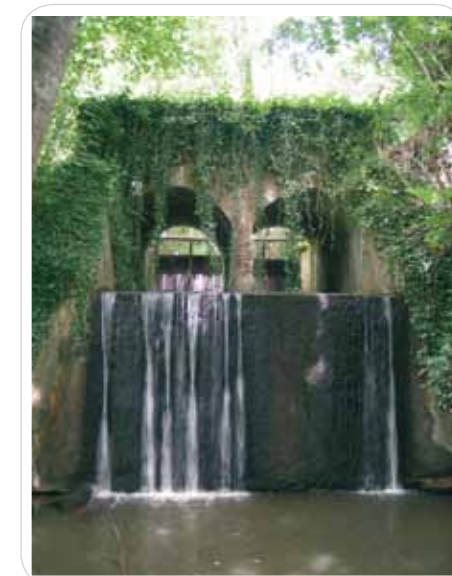
Ouvrage hydraulique barrant le cours de la Corbionne
