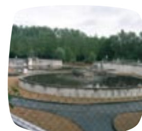
Station d'épuration d'Arjowiggins
