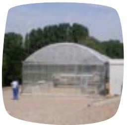
Station de séchage solaire
